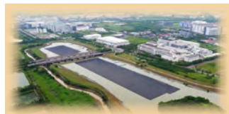
台南公滞池「浮力式太阳能电厂」
