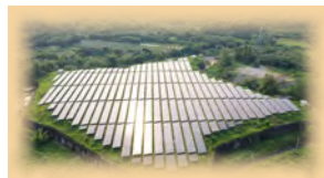
在垃圾掩埋场上建置太阳能系统，打造「成劲关庙电厂」
