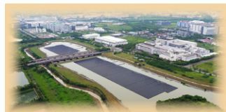
台南公滯池「浮力式太陽能電廠」
