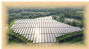
在垃圾掩埋場上建置太陽能系統， 打造「成勁關廟電廠」
